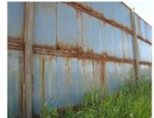
Сквозная коррозия металлических панелей АЭ
