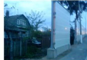
Разрывы для съездов без установки контр-экранов
