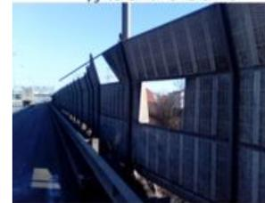
Вандажное разрушение металлического АЭ
