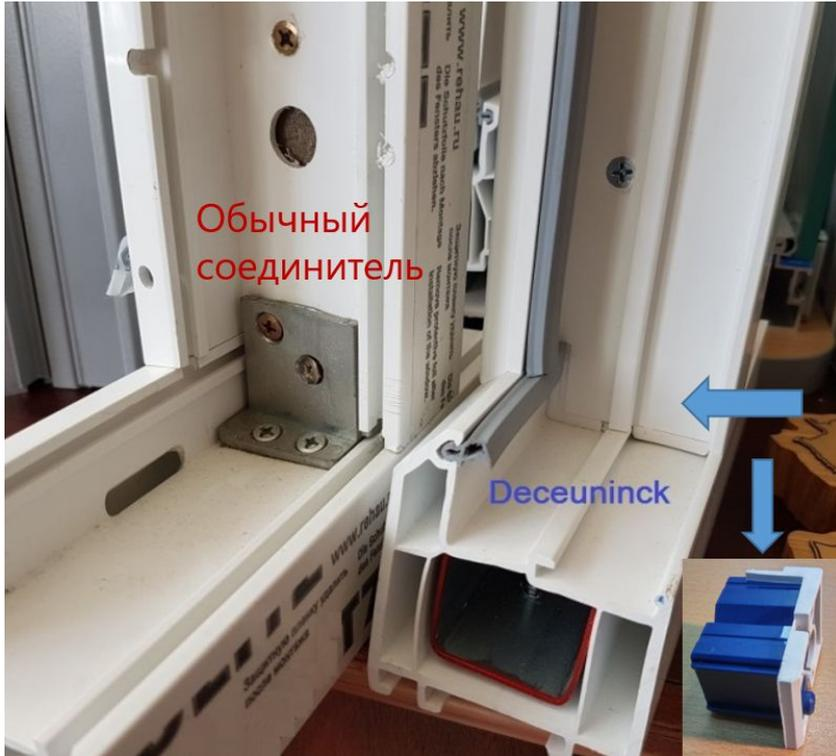
**В системах Deceuninck механический соединитель импоста и рамы комбинированный, выполнен из жесткого пластика и прорезиненного материала:**
