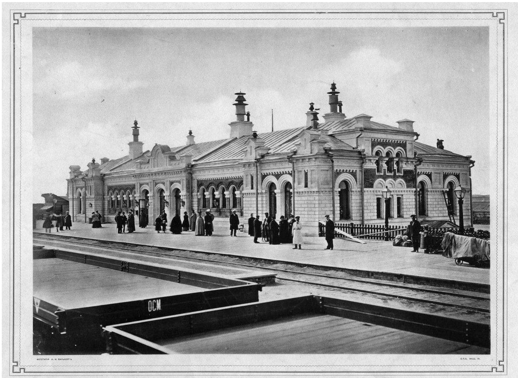
Фото 15 - Пассажирское здание ст. Омск со стороны платформы
