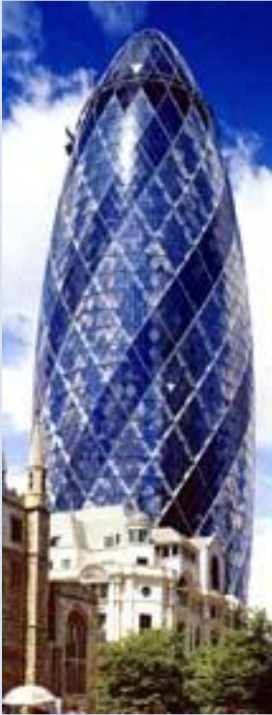
Загальний вигляд будівлі Swiss Re в Лондоні, 2003 арх. Н. Фостер
