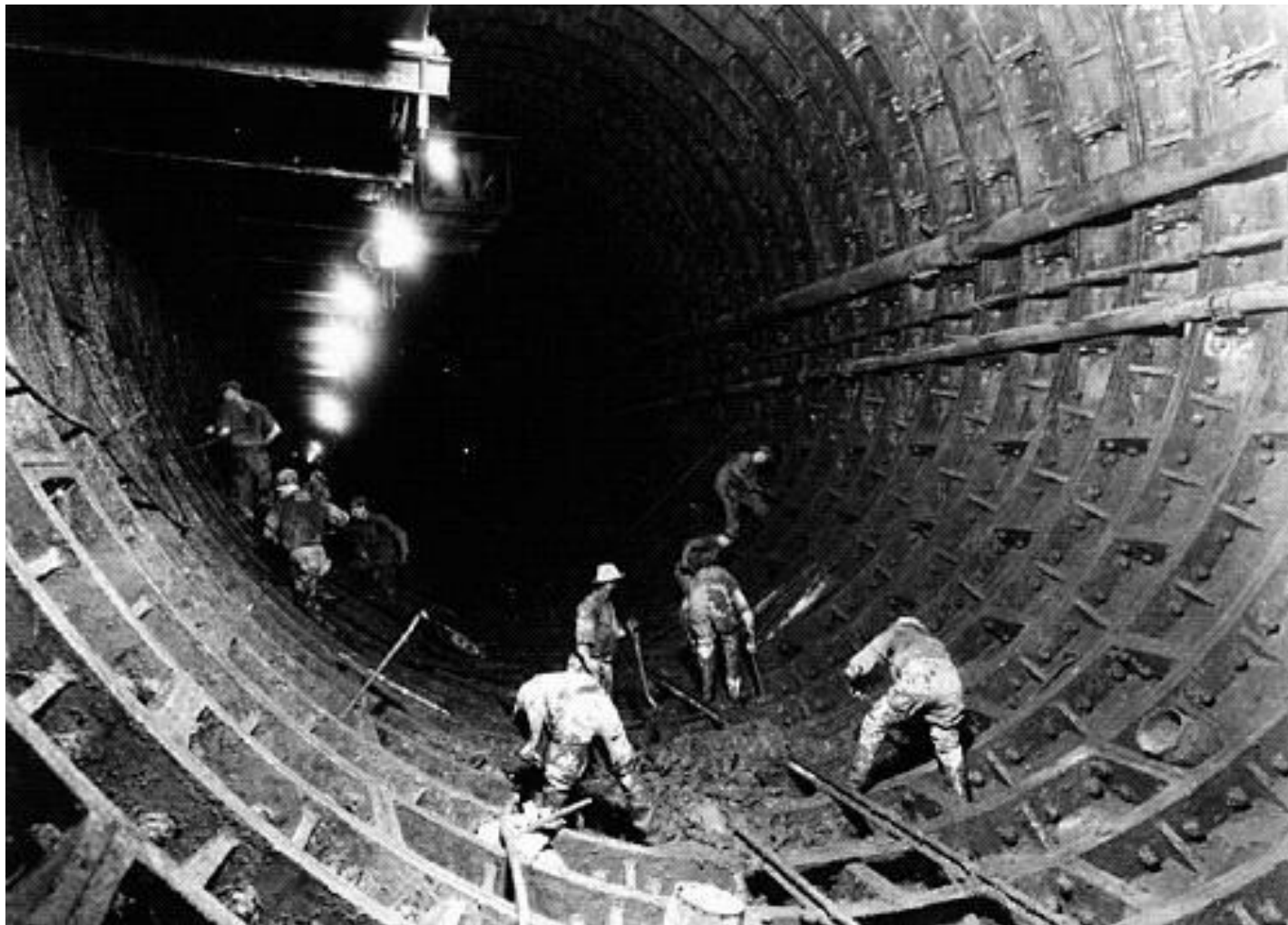
Сооружение тоннеля Линкольна (Нью-Йорк), 1934-1937 гг.
