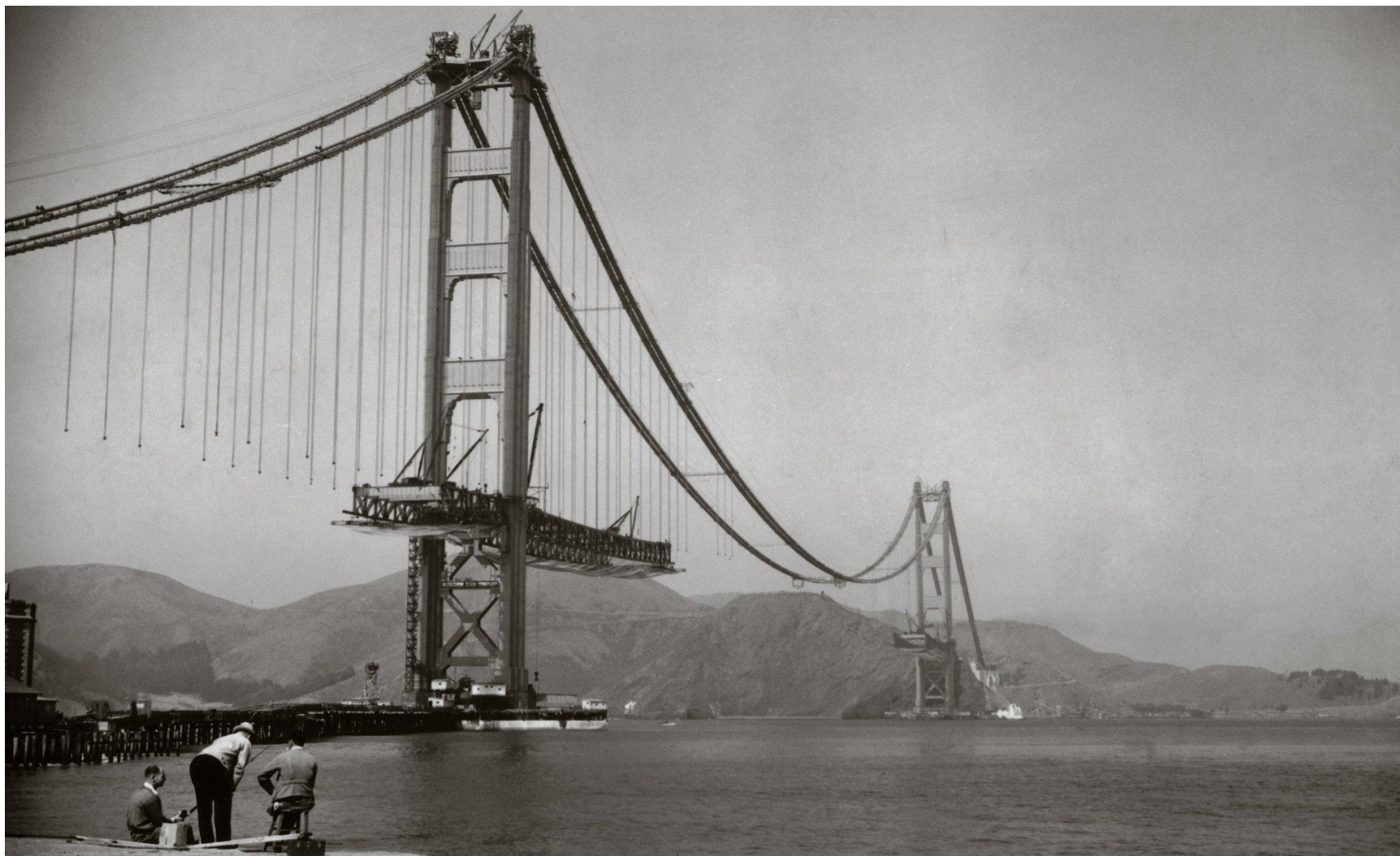
Строительство моста «Золотые ворота», Сан-Франциско, 1933-1937 гг.
