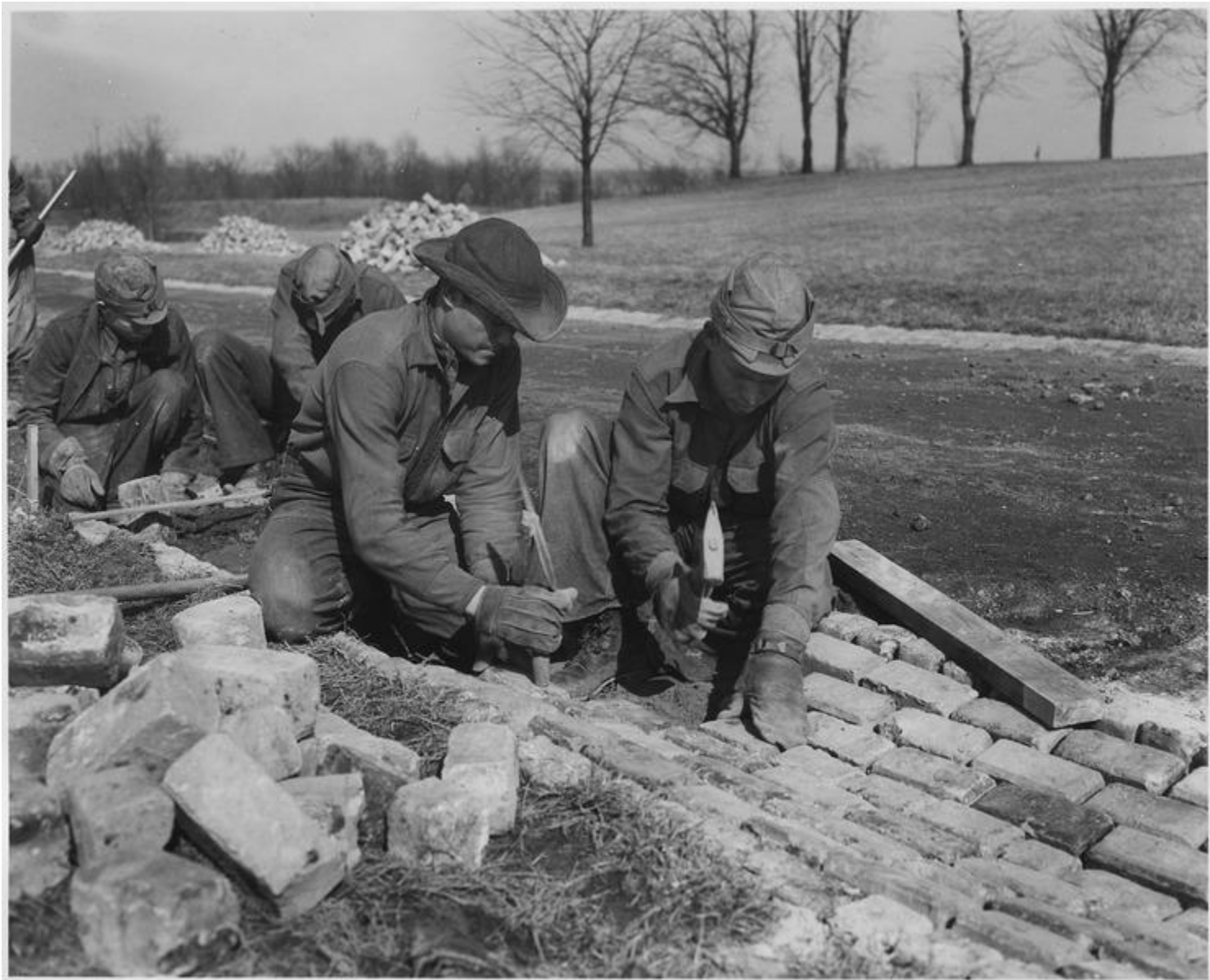
Сотрудники Гражданского корпуса охраны окружающей среды строят дорогу, 1933 г.
