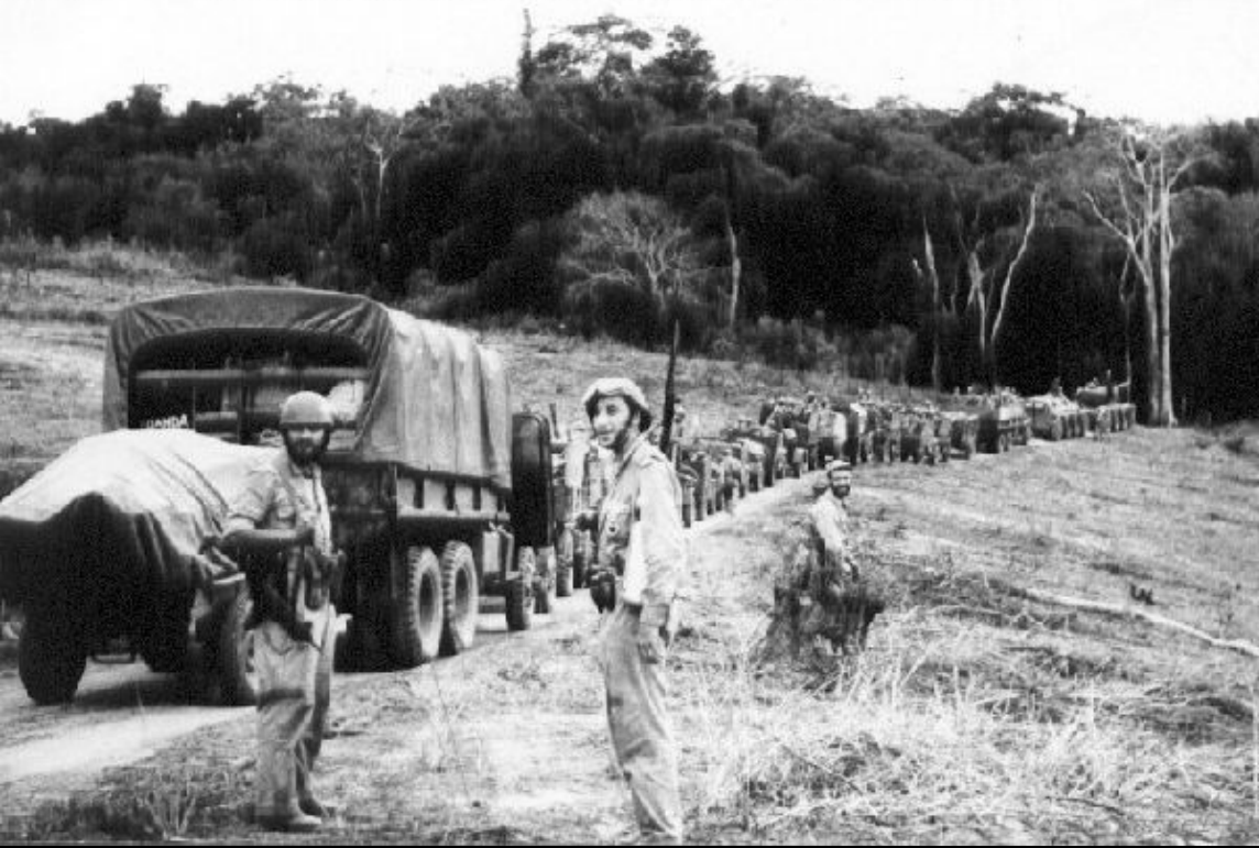
Португальская военная колонна. Мозамбик
