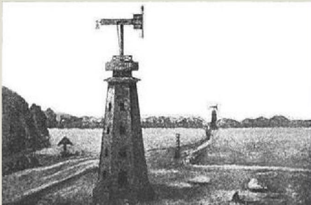
ОПТИЧЕСКИЙ ТЕЛЕГРАФ Кулибина
