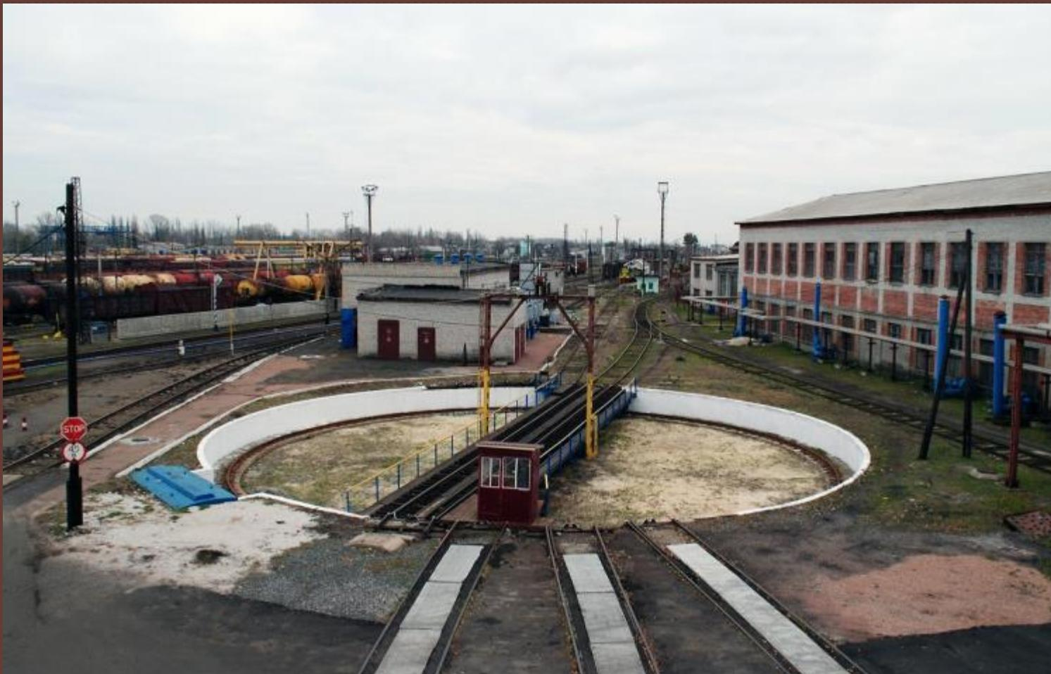
Локомотивное депо – сюда прибывают поезда после своей работы, здесь их осматривают, ремонтируют и приводят в рабочее состояние.
