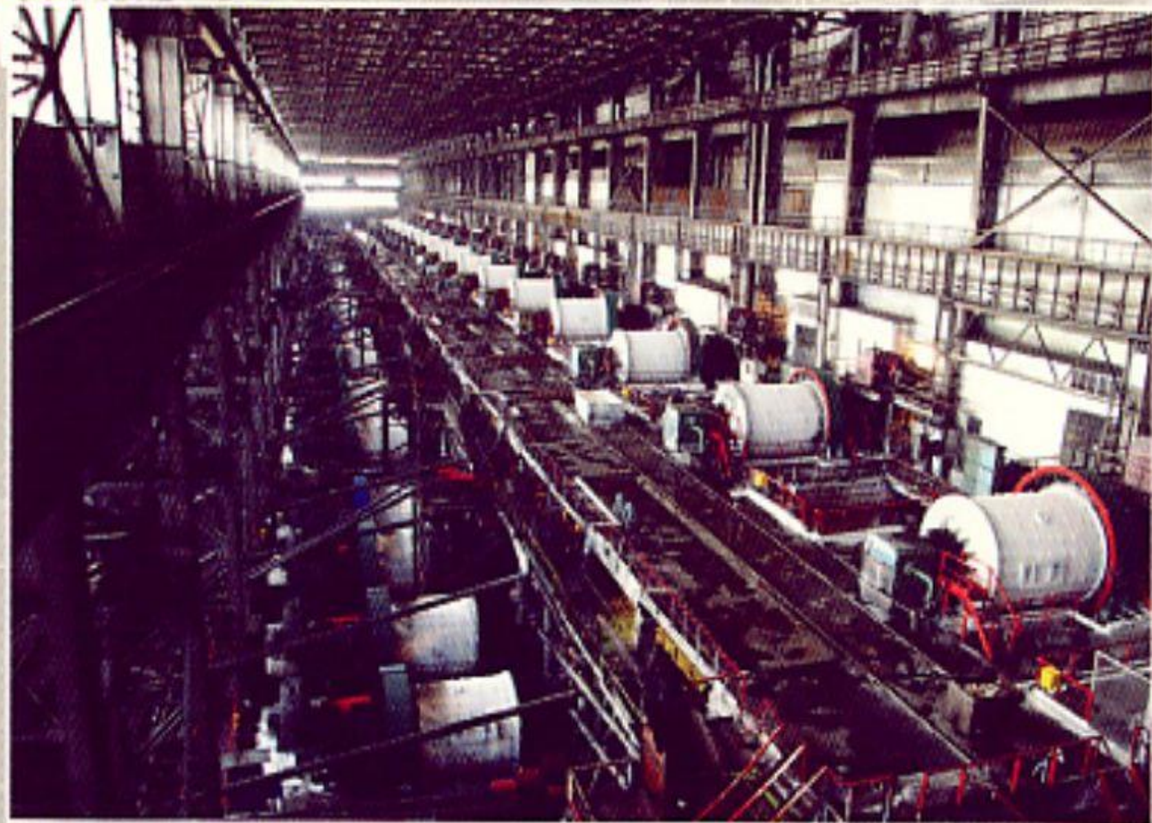
Мельничный пролет цеха обогащения обогатительной фабрики
