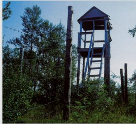
Строится ограда в лесной зоне Соловецкого лагеря, с которой острове был преобразован
