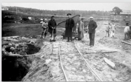
Строительство на Соловках узкоколейной железной дороги. Фото сир., 1924-й год
