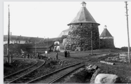
Строительство укреплений на Соловках
