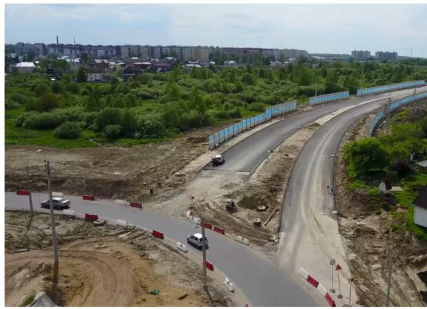
Строительство Транспортного обхода города Красное Село (2015-2019 гг.)
