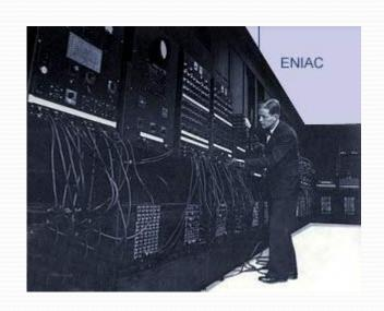
**В 1946 году** в США появилась первая электронная вычислительная машина, которая получила название **ЭНИАК** (ENIAC — Electronic Numerical Integrator and Calculator, в переводе "электронный численный интегратор и калькулятор"). От нее начался отсчет пути, по которому пошло развитие электронновычислительных машин (ЭВМ).
