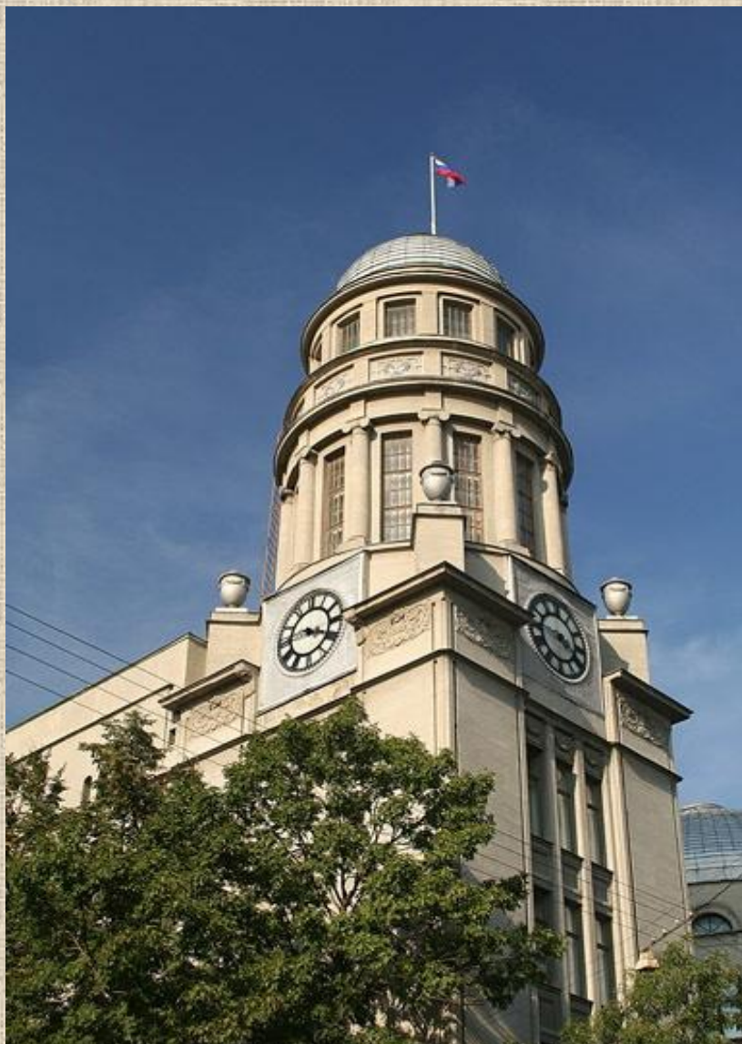
Здание Конституционного суда
