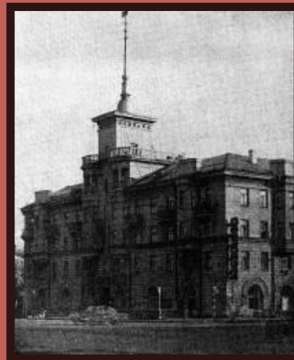
Жилой дом «под шпилем» на Октябрьской площади.1956
