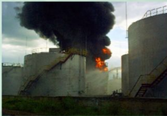
Пожар на нефтеперерабатывающем заводе.
