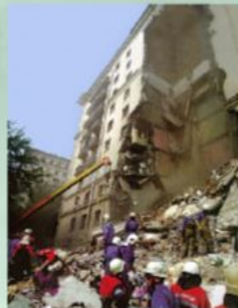
Последствия взрыва газа в жилом доме.
