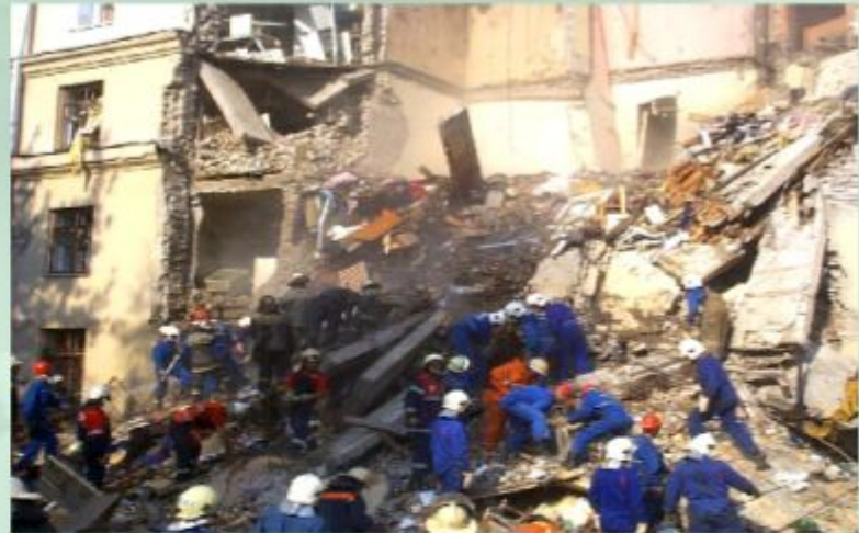
Обрушение жилого дома.
