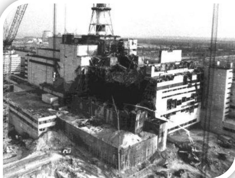
Разрушенный 4-й энергоблок
