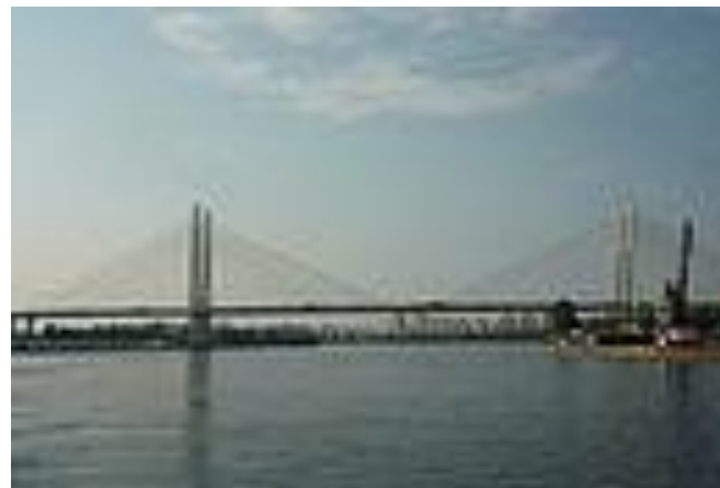
Большой Обуховский мост
