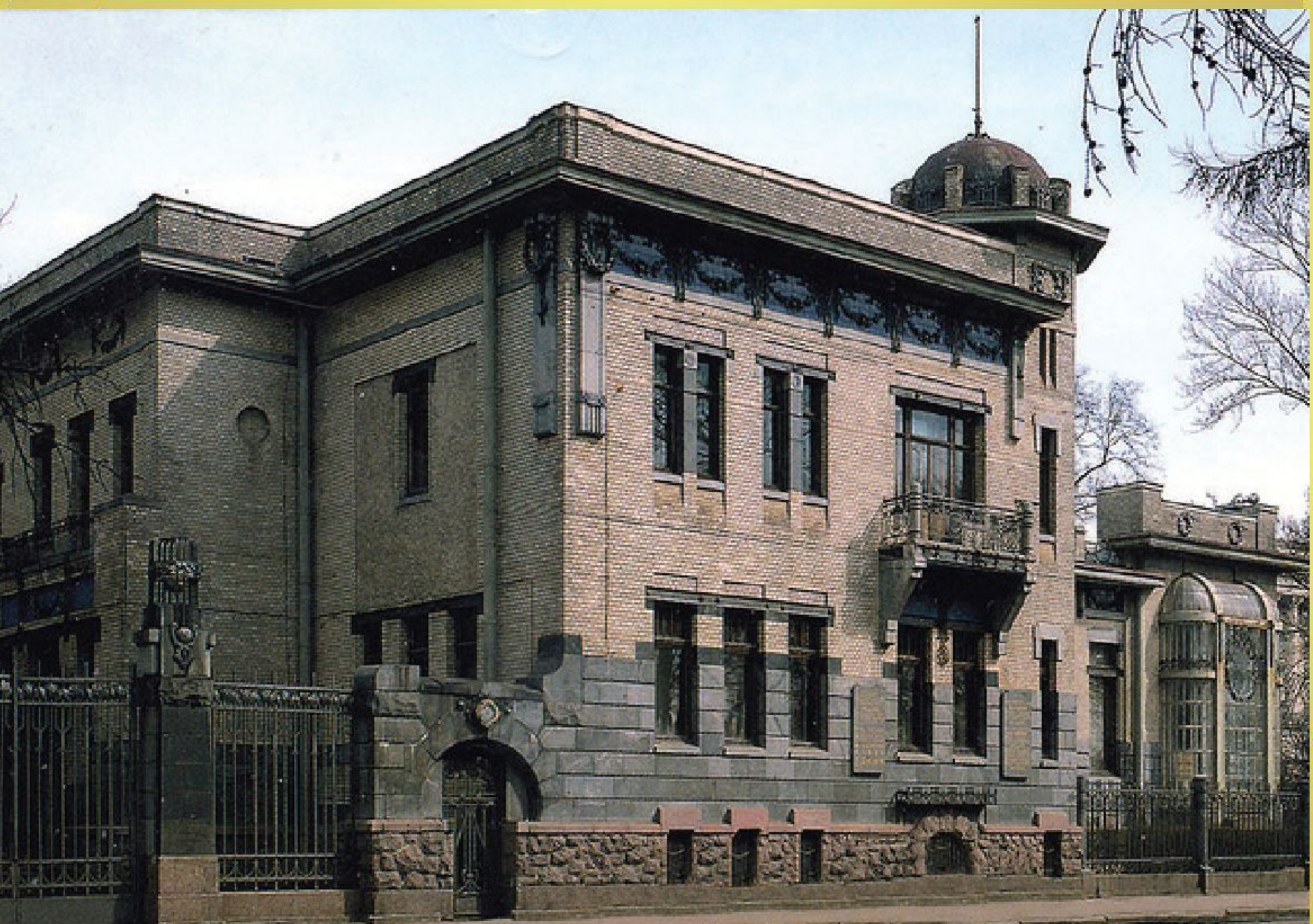
Особняк М.Ф. Кшесинской. Архитектор А.И. фон Гоген
