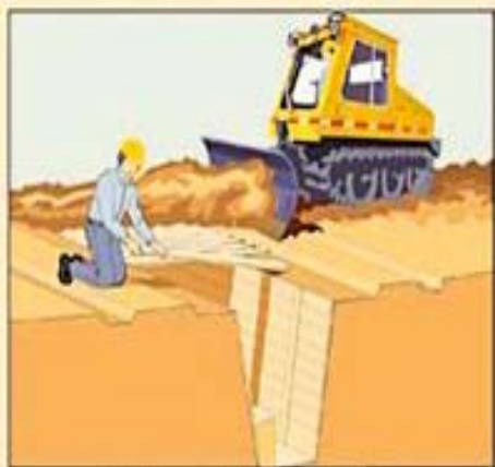
Оборудование перекрытой щели
