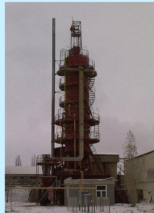
Шахтная печь для обжига известки на предприятии ООО "Силекатобетон" г. Сумы, Украина
