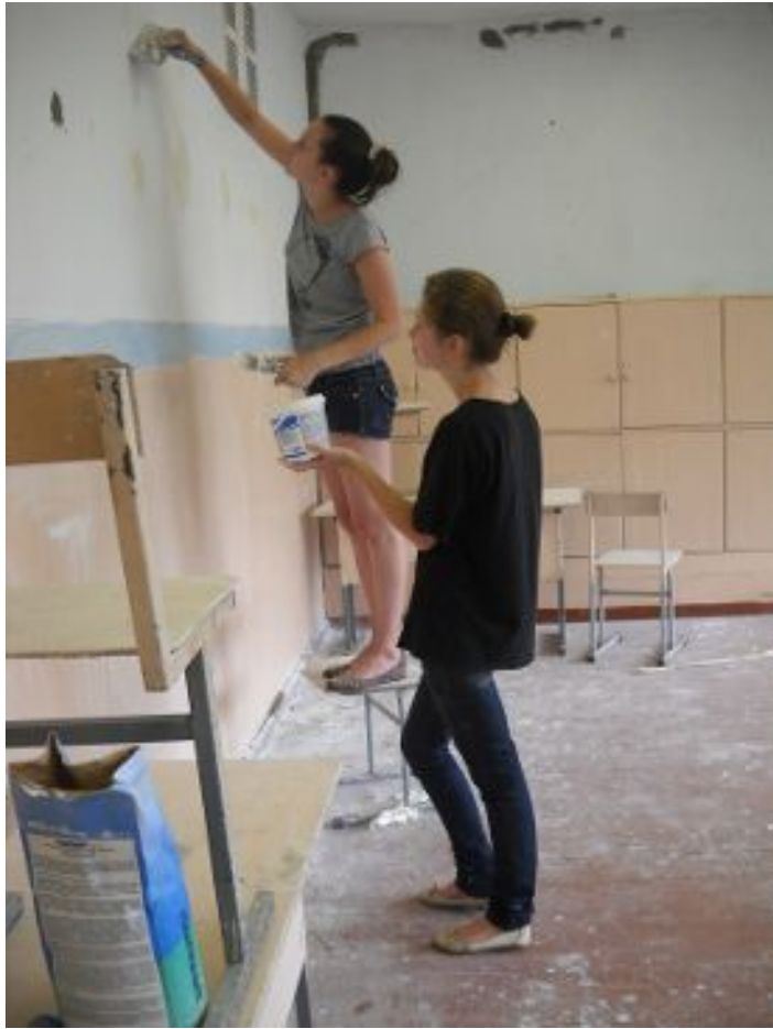
Ремонт классного кабинета своими силами
