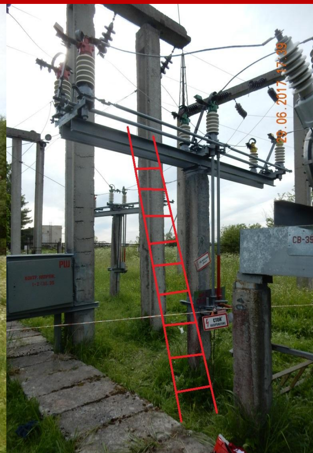
Фото 4 Как была установлена лестница
