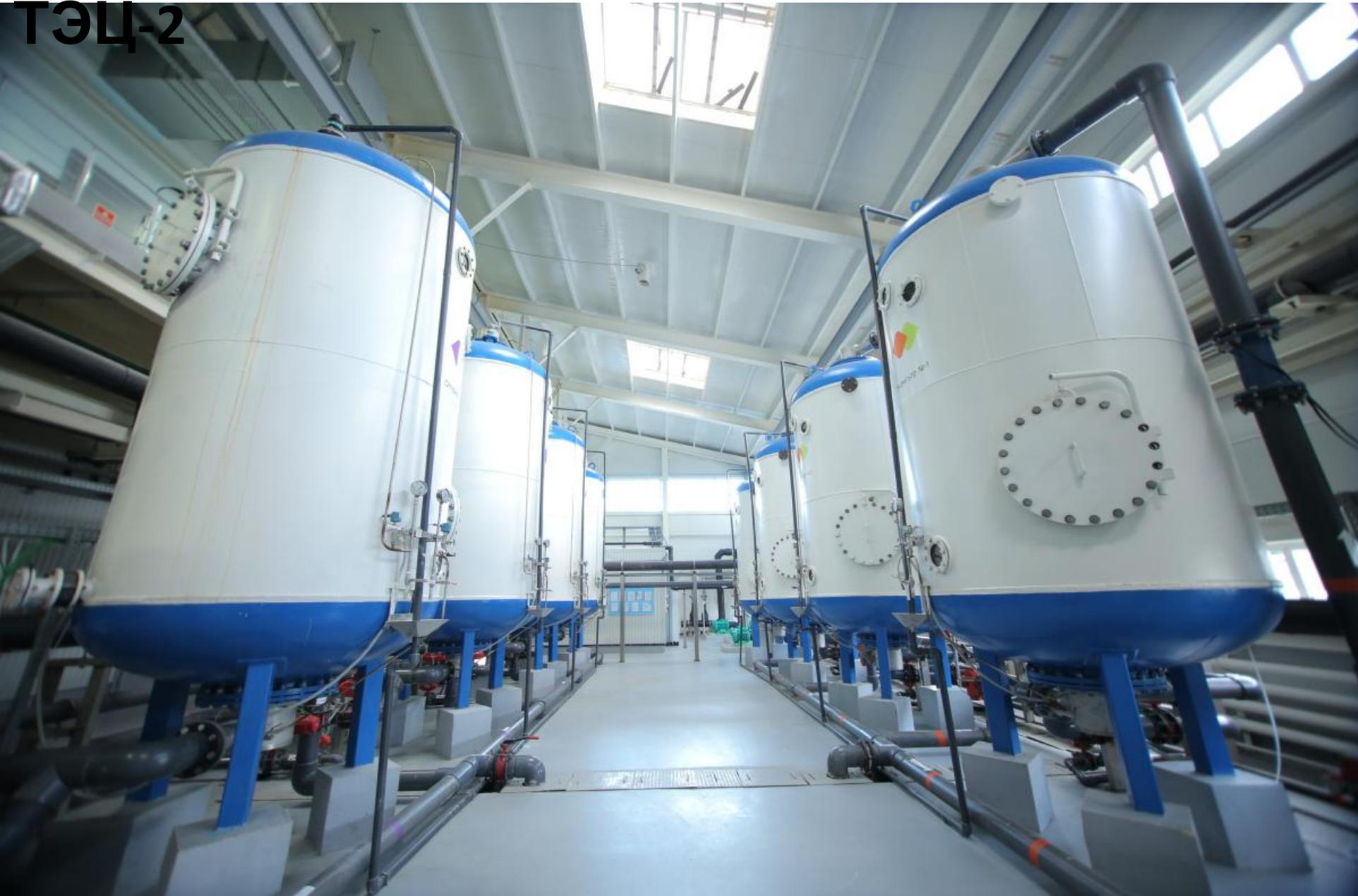
Просачиваясь между зернами ионита, обрабатываемая вода обменивает часть ионов растворенных в ней электролитов на эквивалентное количество ионов ионита, в результате чего изменяется состав, как обрабатываемой воды, так и самого ионита.
