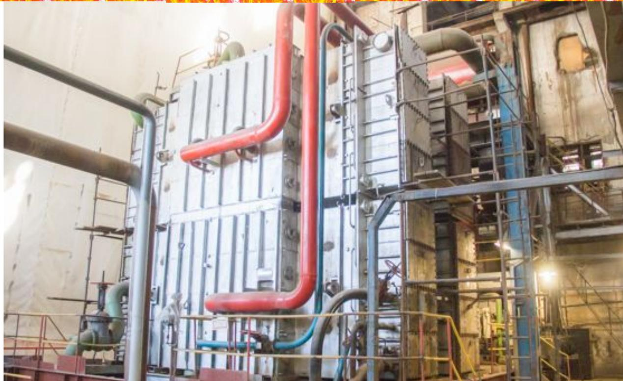
Обессоливание воды дистилляцией — это старейший, хорошо освоенный, но **энергоёмкий** процесс, который используют на высокопроизводительных станциях и для сильноминерализов
