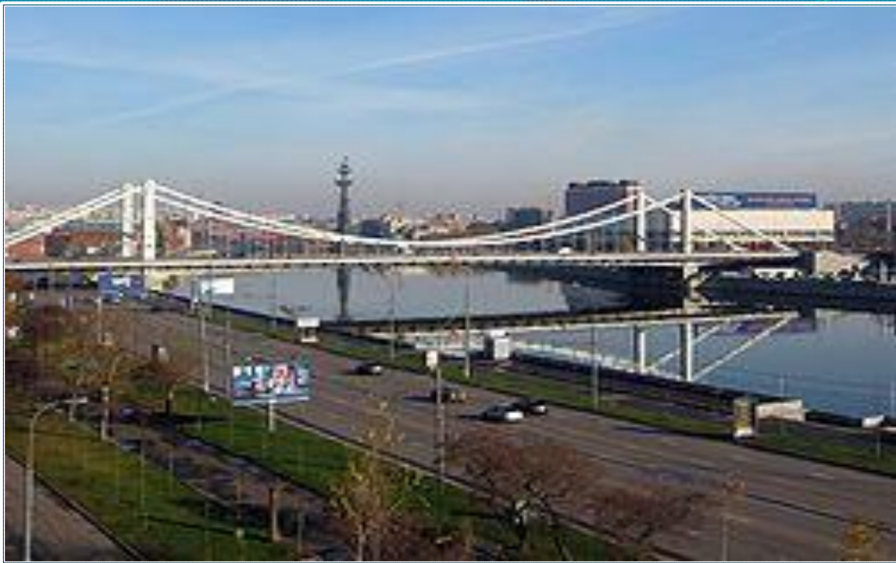
Крымский мост г. Москва
