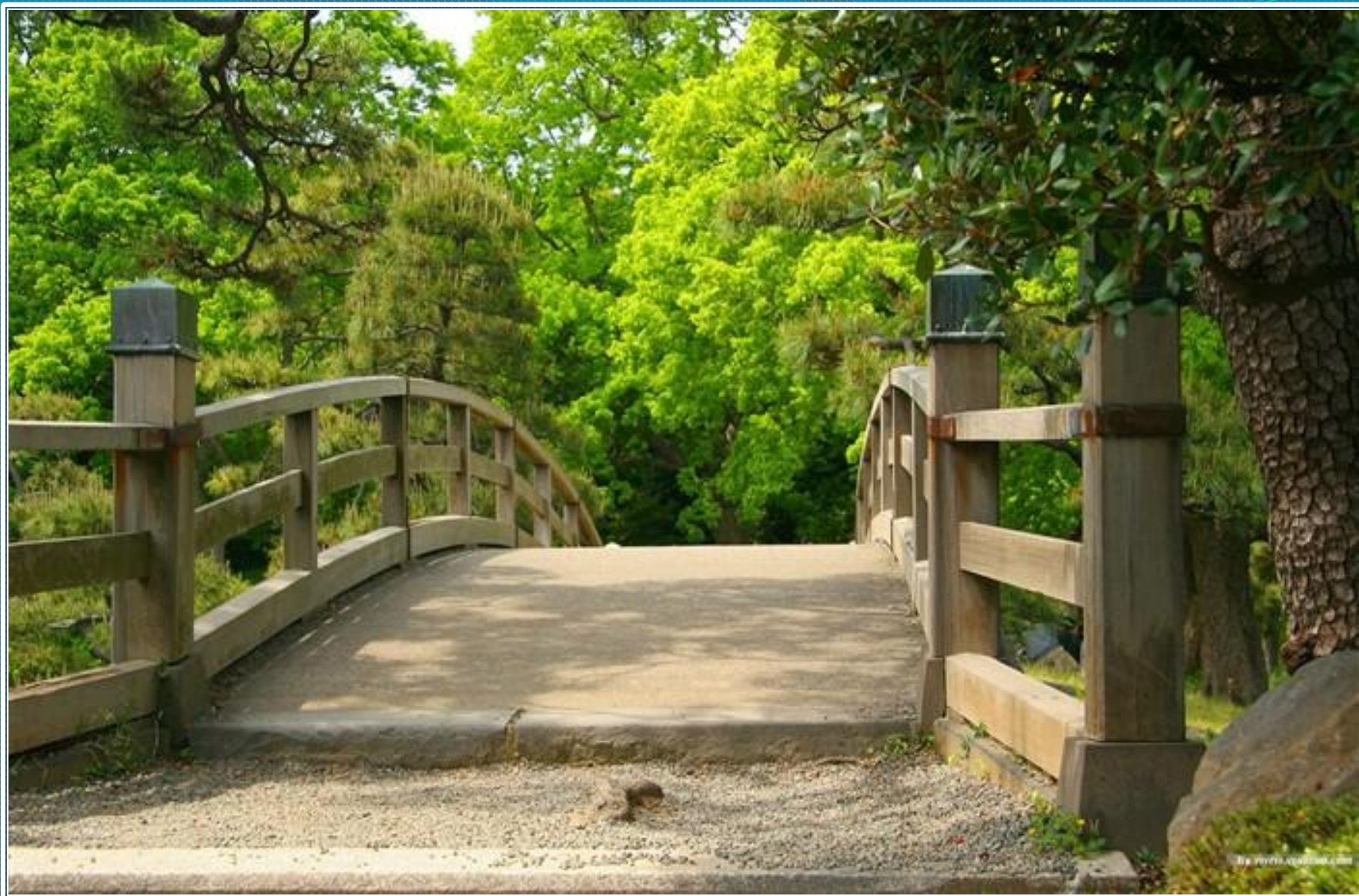
Деревянный мост через глубокий овраг
