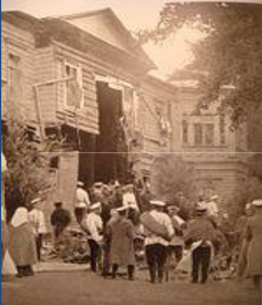
Разрушенное вследствие взрыва здание особняка Столыпина на Аптекарском острове
