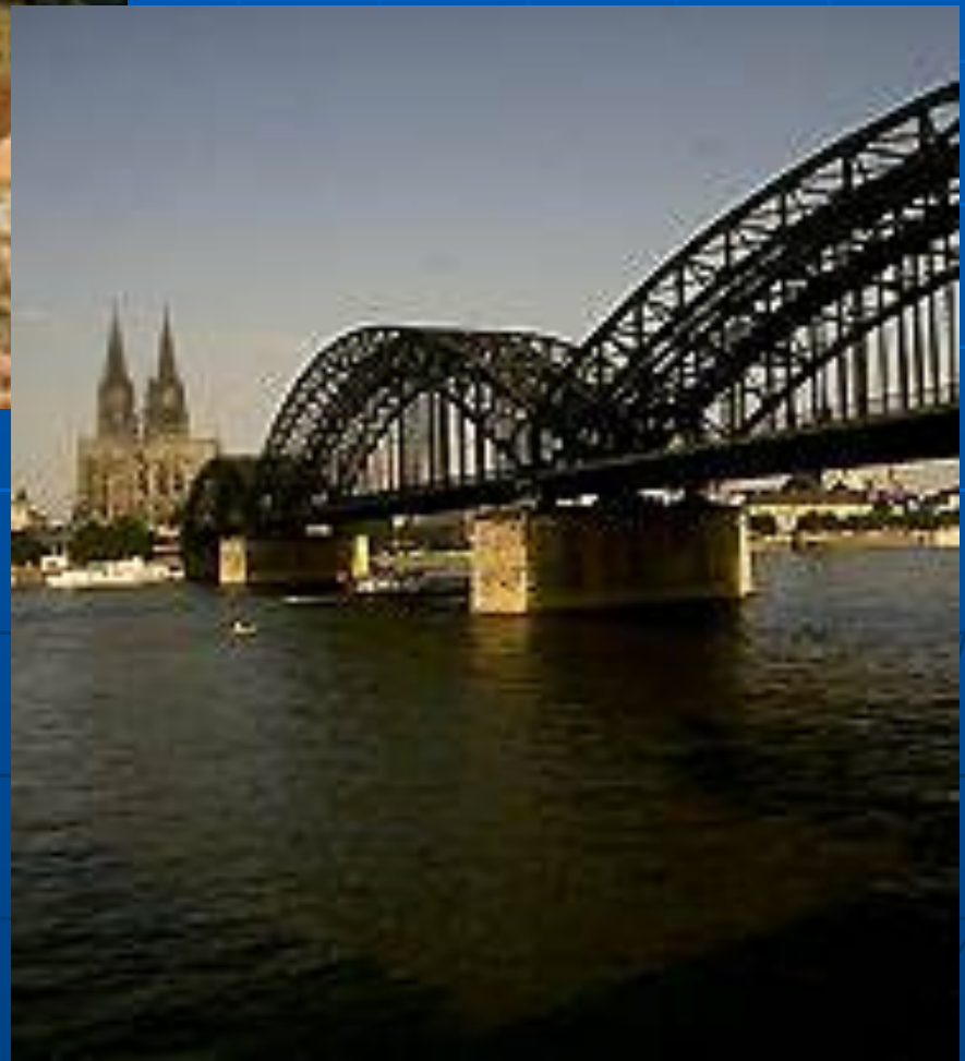
Мост через Рейн.
