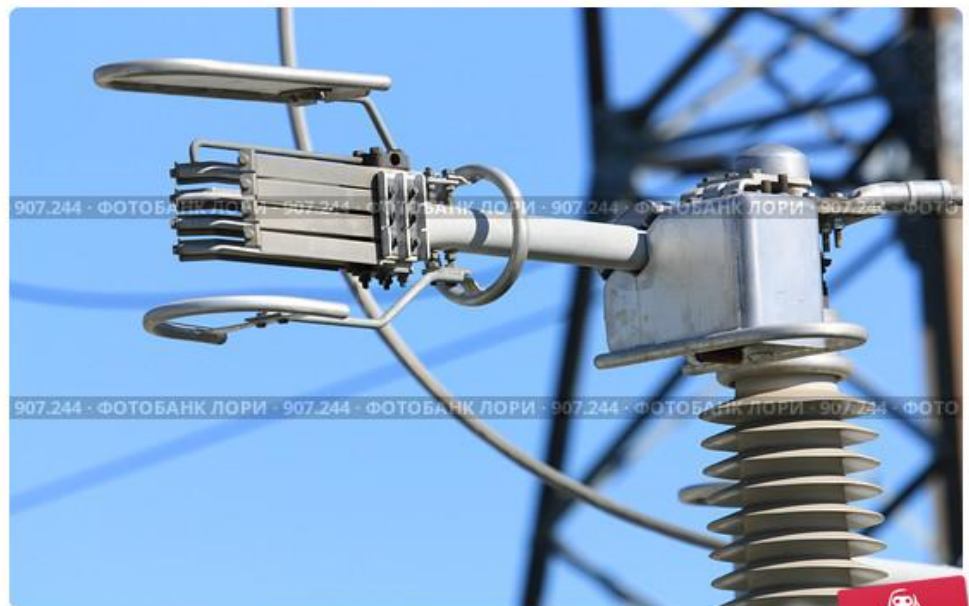
Разъединитель горизонтально-поворотного типа
