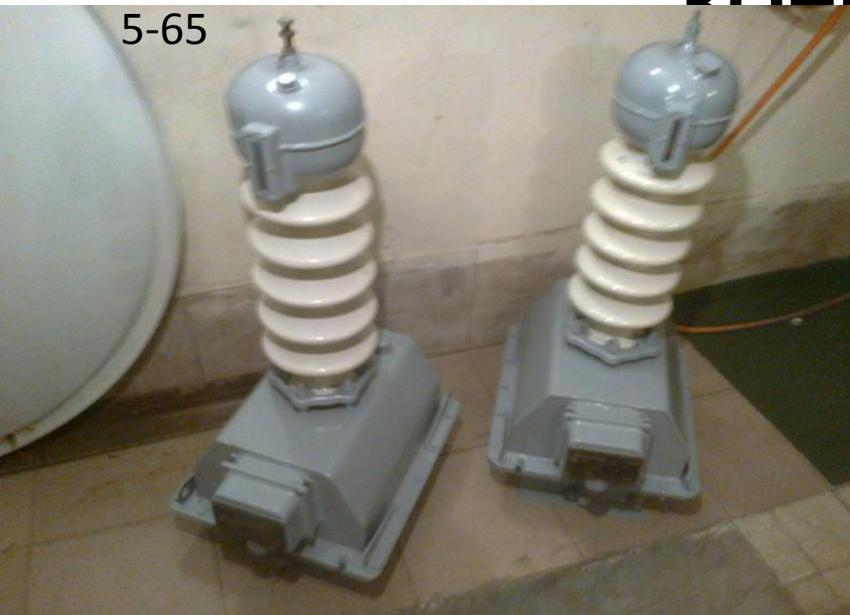
Конструкция трансформатора напряжения до 35 кВ аналогична конструкции силовых трансформаторов. При этом индукция в магнитопроводе значительно меньше, чем у силовых трансформаторов. Это снижает погрешность, позволяет в некоторых случаях проводить испытания индуцированным напряжением.
