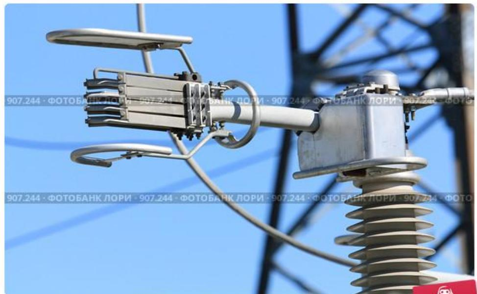
Разъединитель горизонтально-поворотного типа
