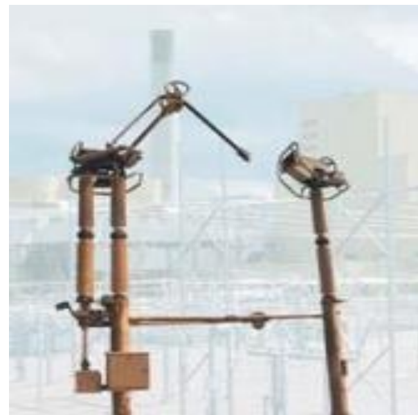
Разъединители наружной установки полупантографного
