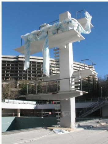
Рис. 3.11. Пример коррозионных процессов в бетоне и арматуре несущих конструкций прыжковой вышки
