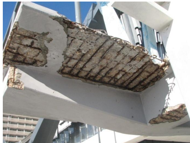
Рис. 3.11. Пример коррозионных процессов в бетоне и арматуре несущих конструкций прыжковой вышки
