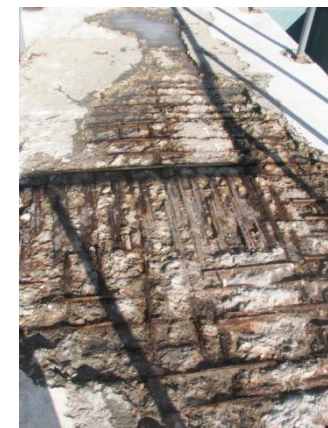
Рис. 3.11. Пример коррозионных процессов в бетоне и арматуре несущих конструкций прыжковой вышки
