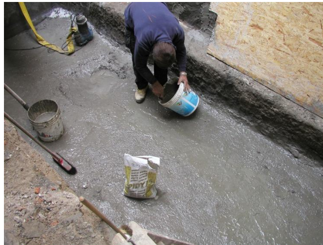
Рис. 3.9. Пример использования материалов, обладающих высокой адгезией при ремонте различных покрытий
