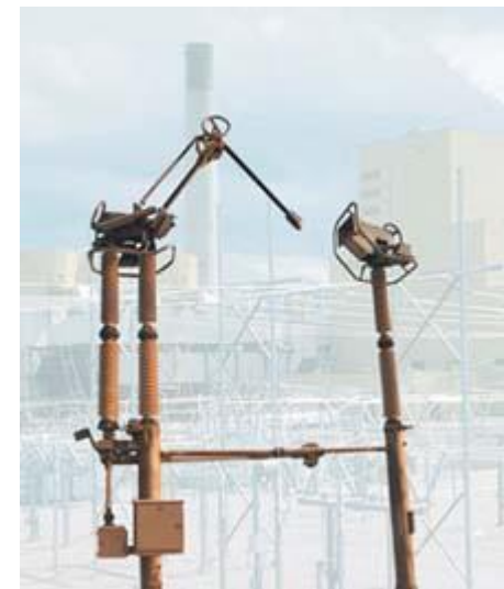
Полупантографный разъединитель
