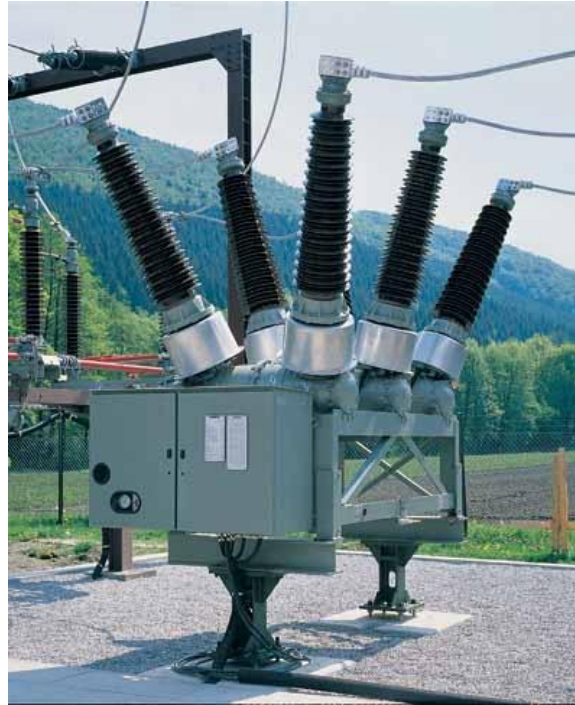
Элегазовый баковый выключатель ЗАР1DT 145 кВ
