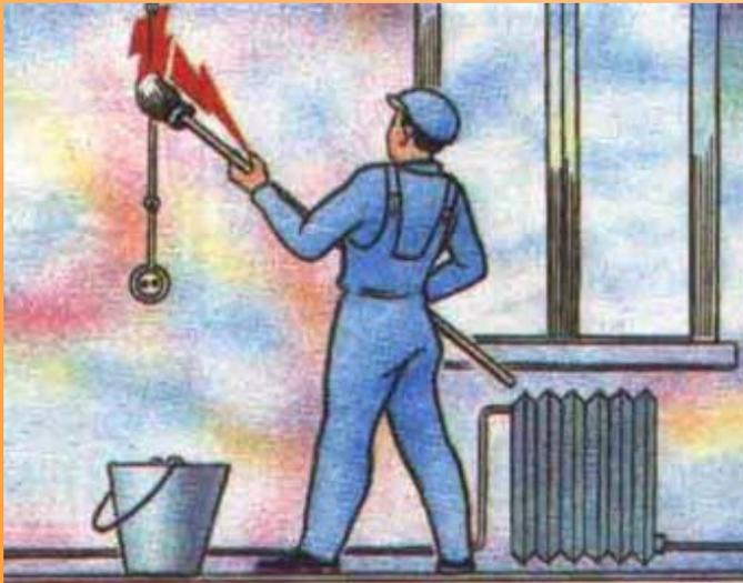
**Неосторожное обращение с оголенными токоведущими предметами штепсельных гнезд, штырей, штепсельных вилок, внутренних частей электропатрона, перетирание изоляции в местах где провода перегибаются (у входа в вилку), пропускание провода под трубами в ванной, при покраски стен с наружной электропроводкой**
