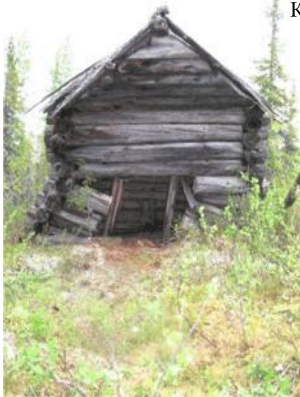
Часовня представляет собой бревенчатое одноэтажное здание с двухскатной дощатой крышей. Вход в часовню сориентирован на восток. Имеется одно окно. Пол дощатый, в северо-западном углу выпилено отверстие для пня. Частично поврежден южный скат крыши и нижние венцы фасада. Внутри часовни были обнаружены надписи, оставленные миссионерами в начале XX века.
