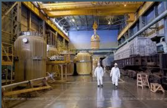
предприятия по переработке или изготовлению ядерного топлива
