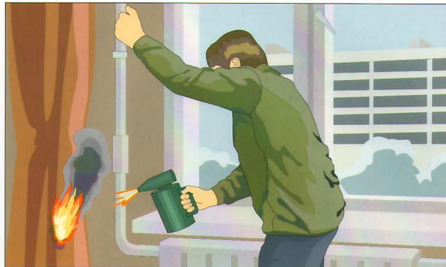
Отогревание замёрзших труб паяльными лампами и факелами
