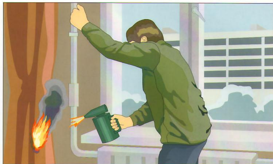
Отогревание замёрзших труб паяльными лампами и факелами
