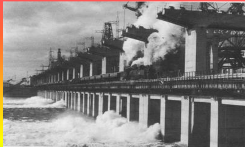
Вид на ГЭС со стороны нижнего бьефа. 1959г.
