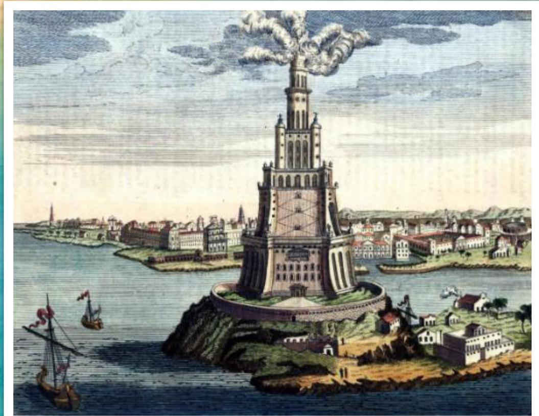
Вдоль внутренней стены проходил наклонный въезд, на котором свободно могла разойтись пара вьючных животных. В середине маяка имелась шахта, ведущая от нижних помещений вверх к осветительной системе. С помощью канатной тяги на верхние этажи можно было поднимать необходимые грузы. Снаружи маяк был облицован белым мрамором. На строительство было израсходовано 800 талантов (стоимость 20 800 кг серебра, что по современным оценкам равняется 10 миллионам немецких марок)
