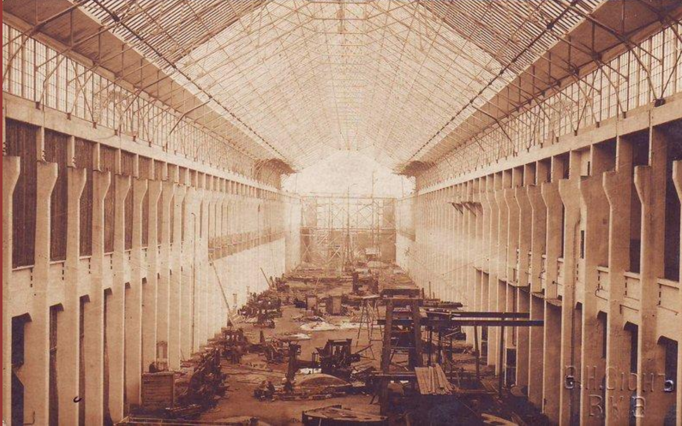
Строительство завода «Электросила» в Харькове – флагмана электромашиностроения СССР. 1915 г.
