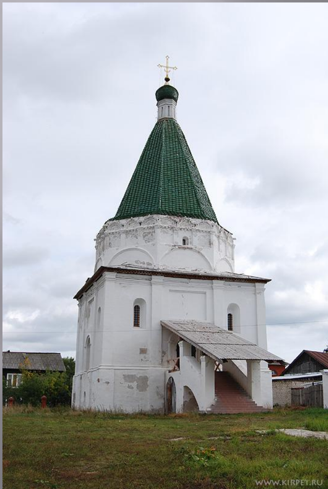
НИКОЛЬСКАЯ ЦЕРКОВЬ БАЛАХНЫ
