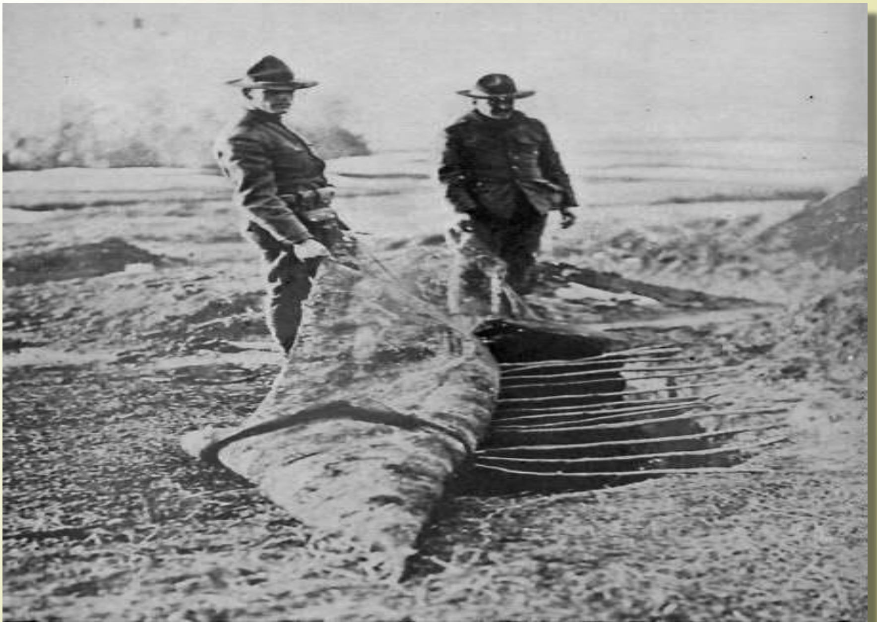
Траншеи, покрытые травяными
