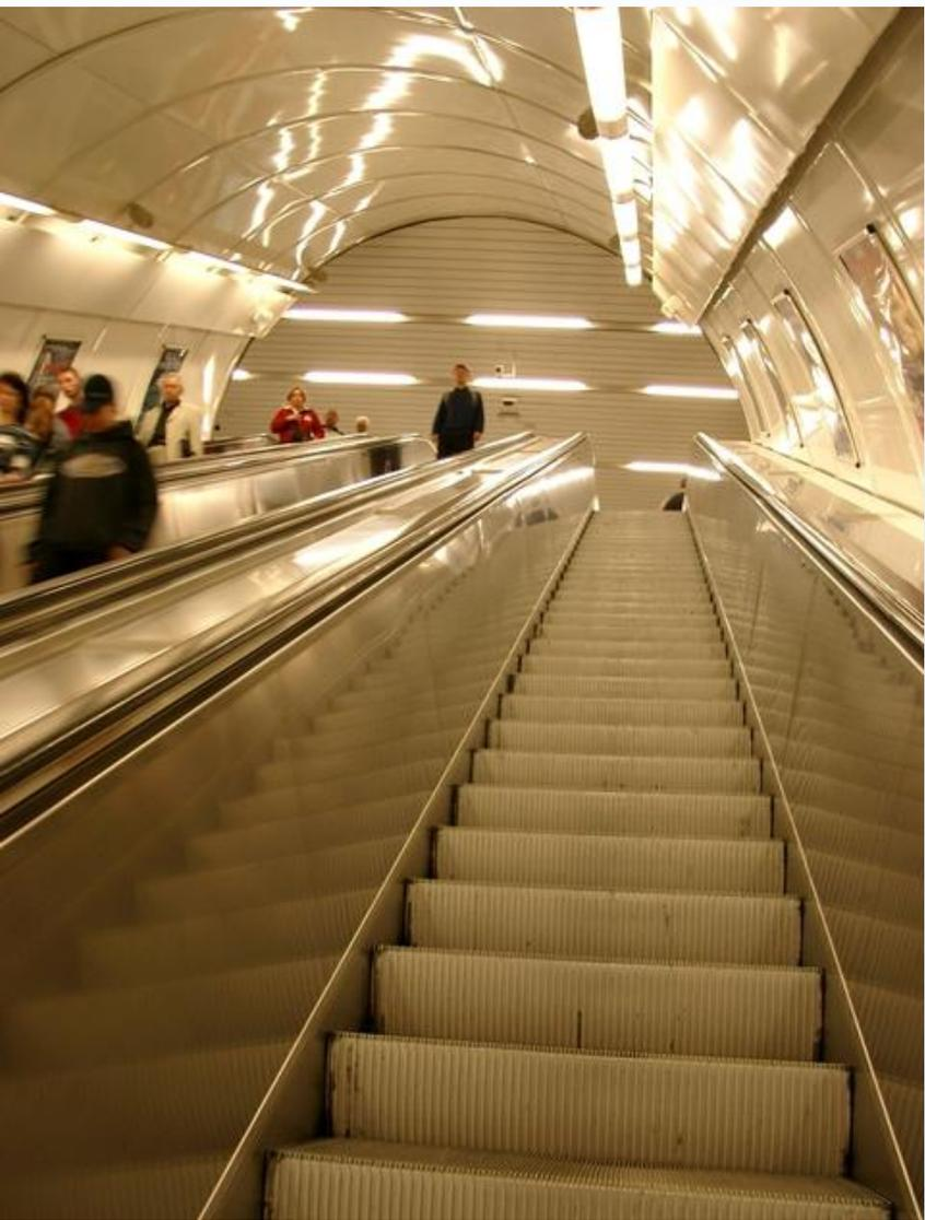
Причиной опасных ситуаций на нем могут стать резкая остановка, неожиданный разгон или разрушение ленты эскалатора.
