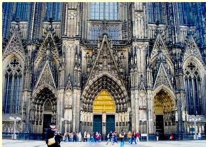
Кёльн. Фасад Домского собора.
