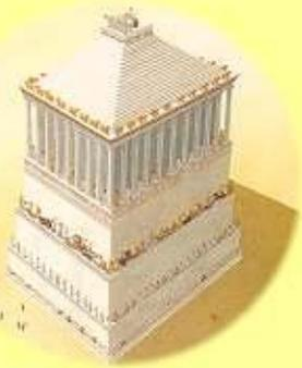
Усыпальница царя **Карии** Мавсола (умер в 353 до н. э.) Постройка соединяла в себе восточную ступенчатую пирамиду и греческий ионический периптер (архитекторы Сатир и Пифей).
