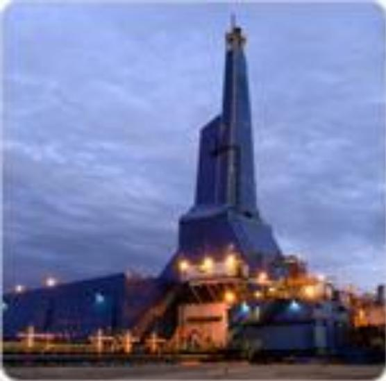
**Наземная буровая установка «Ястреб» спроектирована специально для проекта «Сахалин-1» и является одной из наиболее мощных наземных буровых установок в отрасли. Она предназначена для бурения с берега скважин с большим отходом забоя от вертикали . Высота «Ястреба» – 52 метра, что сопоставимо с высотой 16-этажного дома.**
