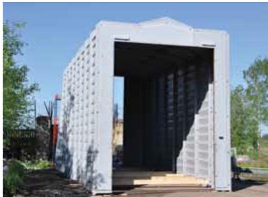
Быстровозводимый ангар выполнен из стеклопластиковых модулей. Модульность конструкции позволяет легко расширять павильоны, легко транспортировать или перемещать по желанию заказчика. Сборка осуществляется на месте установки объекта минимальными силами и без какого-либо специального оборудования.
