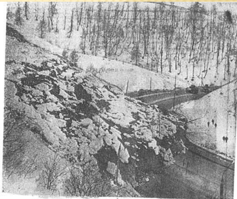
Оползень на Окском съезде, 1974 г. [15]
