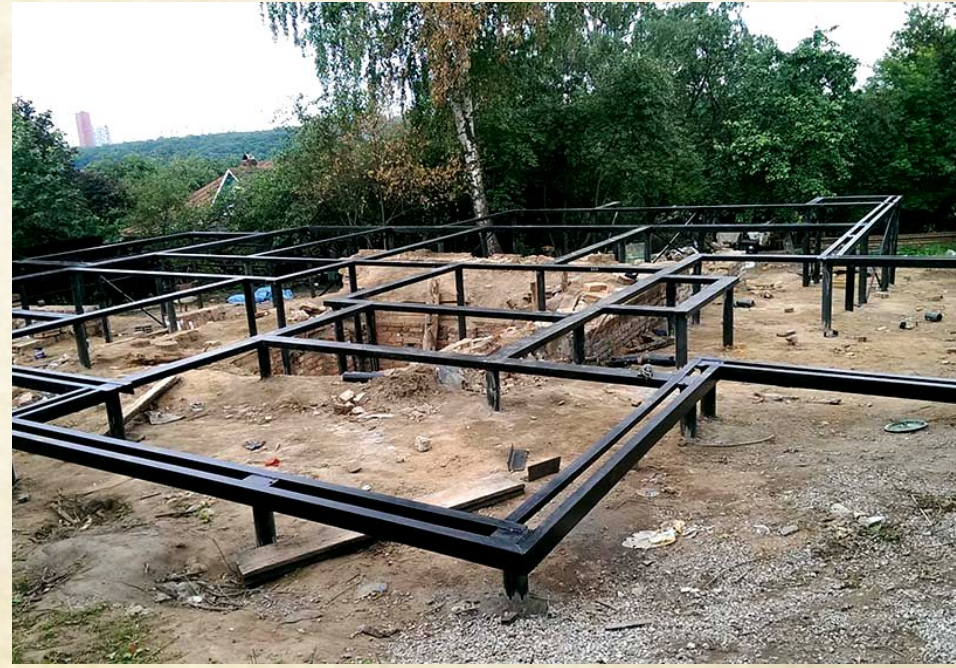
Свайно – винтовой фундамент
