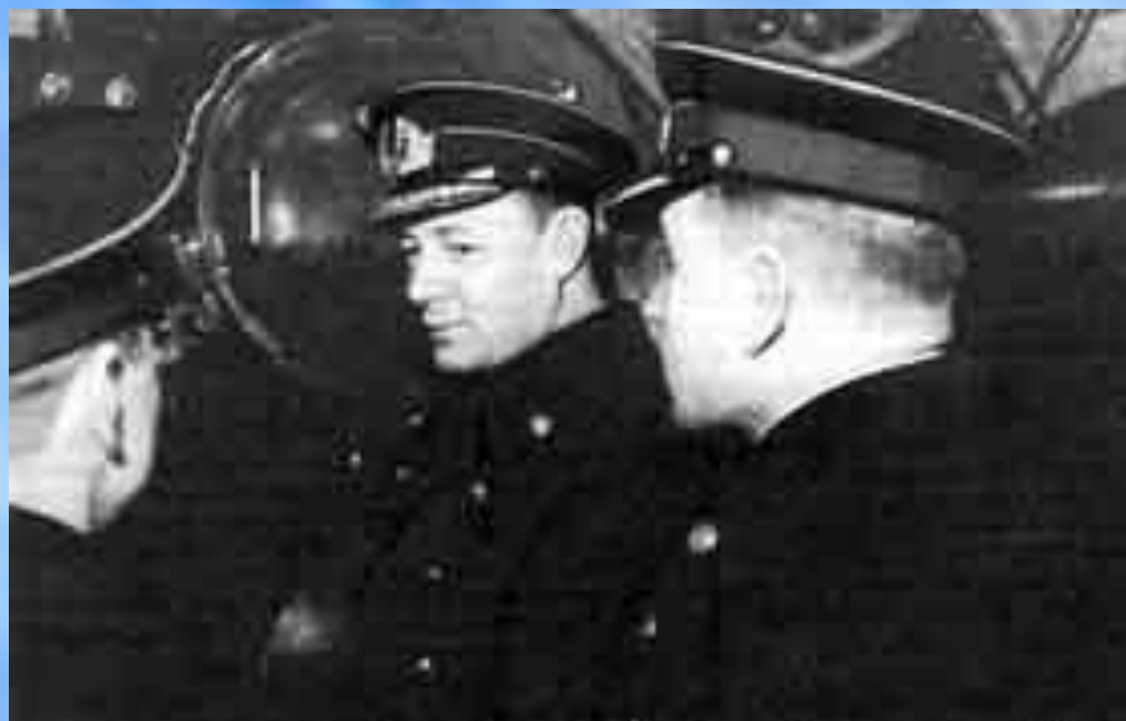
Нарком ВМФ Н.Г.Кузнецов на подводной лодке Щ-403. 1941
