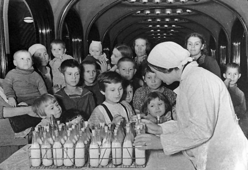
В московском метро, 1941 год, на станции «Маяковская», используемой как бомбоубежище, идет раздача молока детям.
