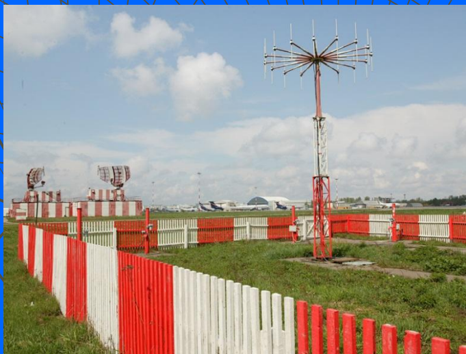
автоматический радиопеленгатор (АРП-95) МВ-ДМВ диапазонов
