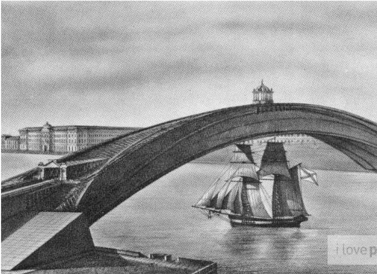
К 1772 году Кулибин разработал несколько проектов 298-метрового одноарочного моста через Неву с деревянными решётчатыми фермами.
