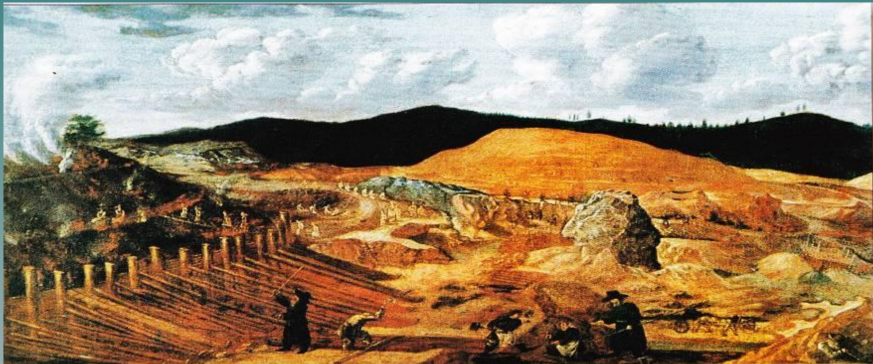
П.И.Перезолов. Вид нижнетагильского Высокогорного железного рудника
